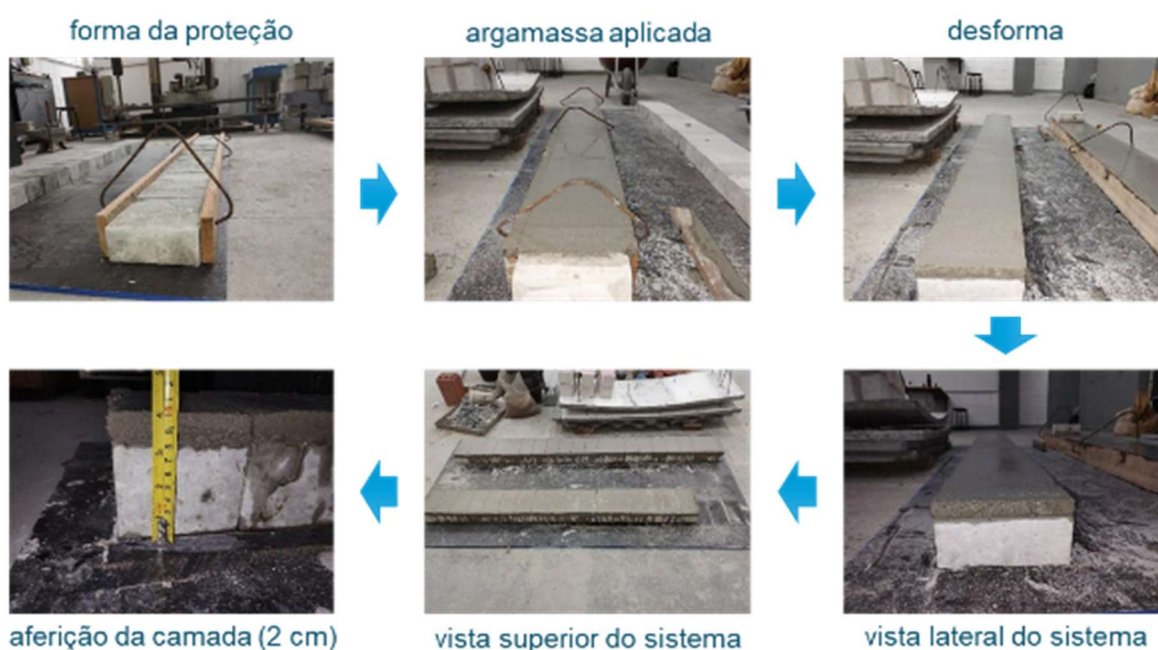
Figura 16 - Processos adotados para a proteção com argamassa.
