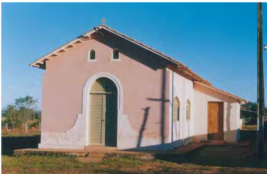
Figura 7 - Comunidade Coqueiro - Catalão (GO): atual Igreja dos Coqueiros. Autor: I. M. Ferreira, jul. 2003.
