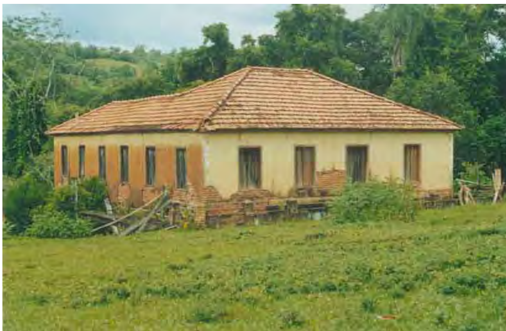
Figura 6 - Comunidade Coqueiro - Catalão (GO): casa construída no início do século XX. Autor: I. M. Ferreira, jan. 2001.
