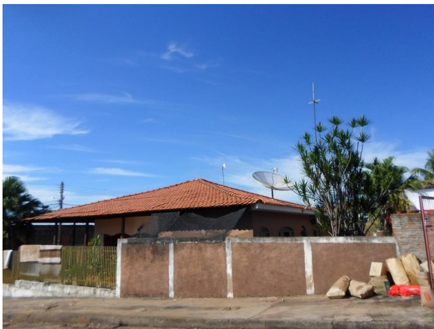
Fotografia 10: Casa de alvenaria na sede do distrito de Teçaindã
