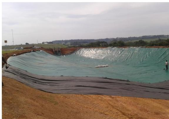
(d) Bacia de contenção de águas pluviais
