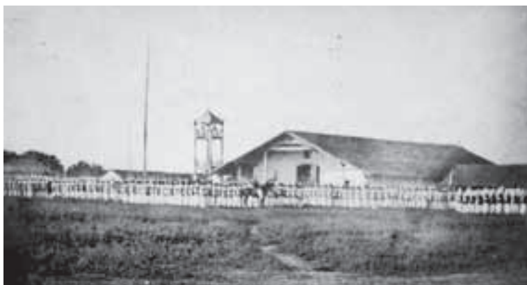
Figura 3.2 Poste telegráfico no acampamento aliado em Rosário. Fonte: Museu Imperial/Ibram/MinC.
