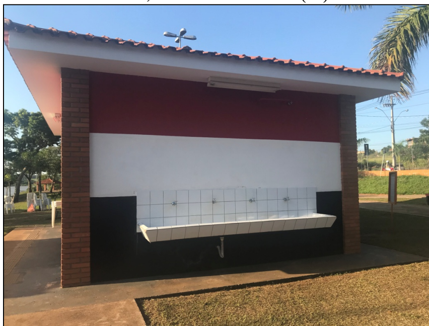
Figura 12: Vista de um dos blocos de sanitários contendo bebedouros no Balneário da Amizade, em Presidente Prudente (SP).
