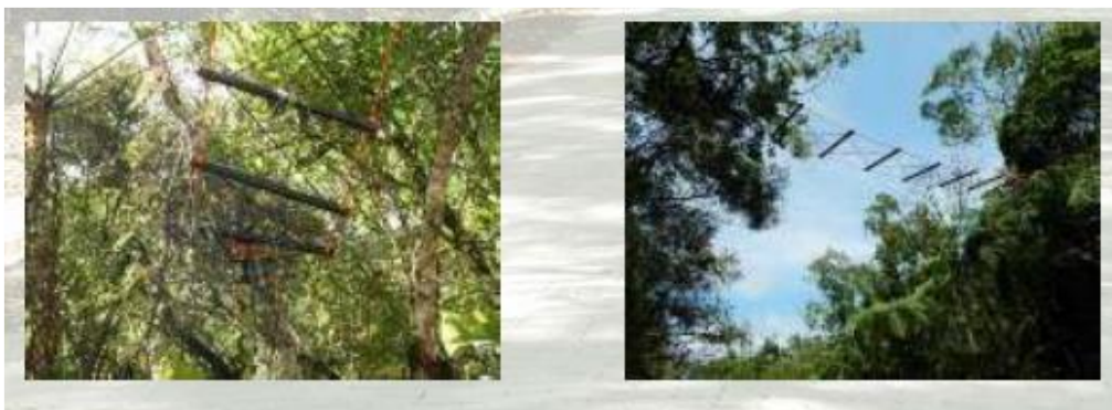
Figura 12: Fotos de zoopassagens aéreas construídas na Rodovia Arlindo Bétio.
