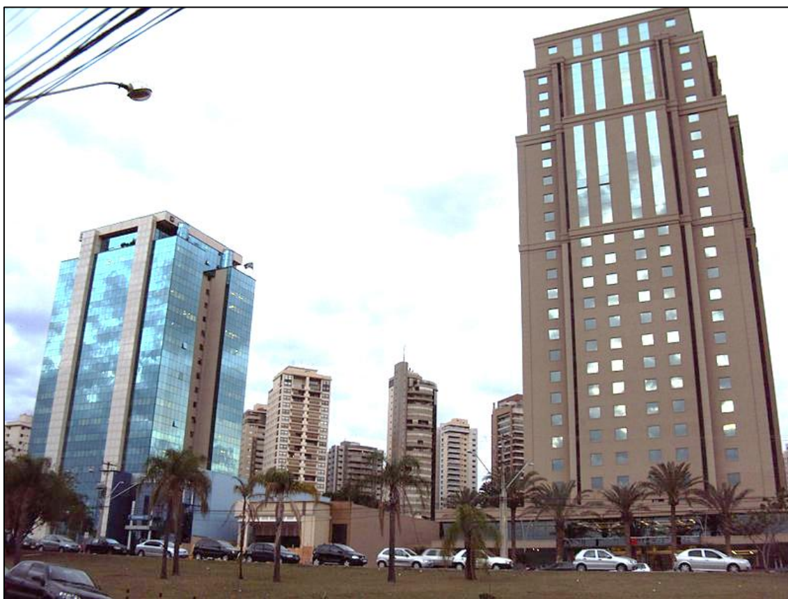
FIGURA 8. RIBEIRÃO PRETO: FOTO PANORÂMICA DOS EDIFÍCIOS TIMES SQUARE E NEW CENTURY. LOCALIZADOS PARALELAMENTE AO AVENIDA PROF. JOÃO FIÚZA.
