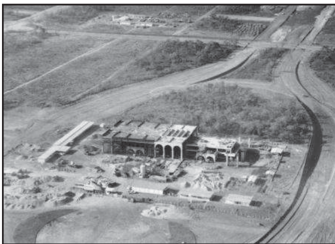
A fotografia mostra a construção do Palácio Araguaia, futura sede do governo estadual, no centro de Palmas, no ano de 1990. Fonte: http://www.skyscrapercity.com/showthread.php?p=73324181 , acessado em 22/07/11.
