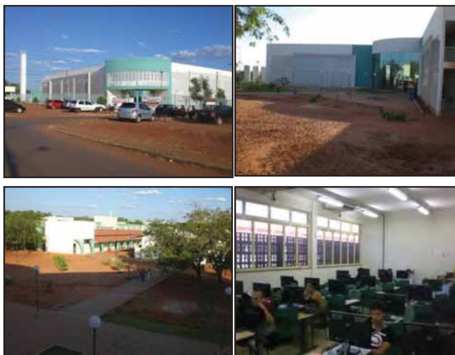
Fotos da Unidade do Bairro Cimba da UFT em Araguaína, funcionando desde Janeiro de 2010. Acima, fotos do bloco administrativo que contém as administrações de cursos e salas de professores. Abaixo, visual dos blocos de salas de aula e de um laboratório de informática. Fonte: arquivo pessoal, 2011.
