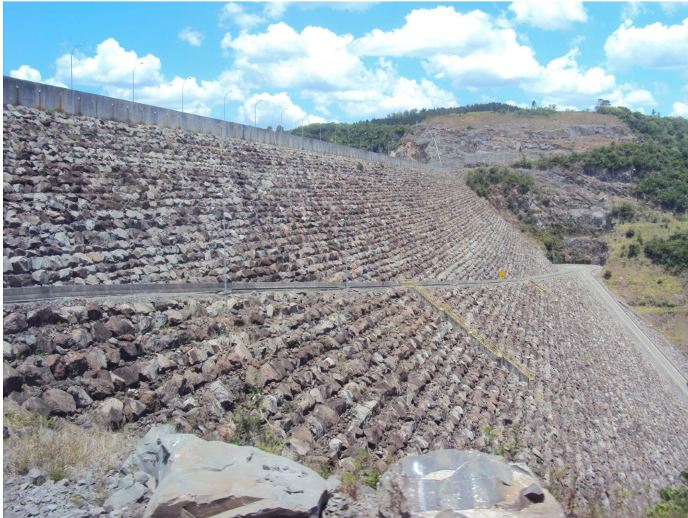
Figura 4 – Barragem de Enrocamento.
