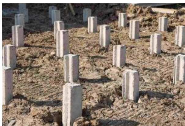
(b) sistema de fundação profunda por estacas.
