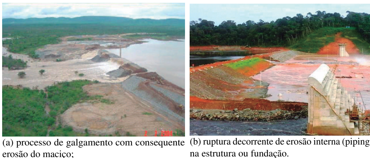
Figura 14 – Modos de falha em estruturas de terra:
