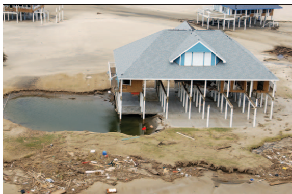
(a) processo de erosão e perda de suporte do solo em lote residencial;
