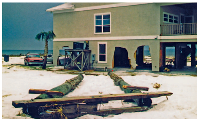
(b) danos estruturais decorrentes do impacto de um fluxo de detritos.
