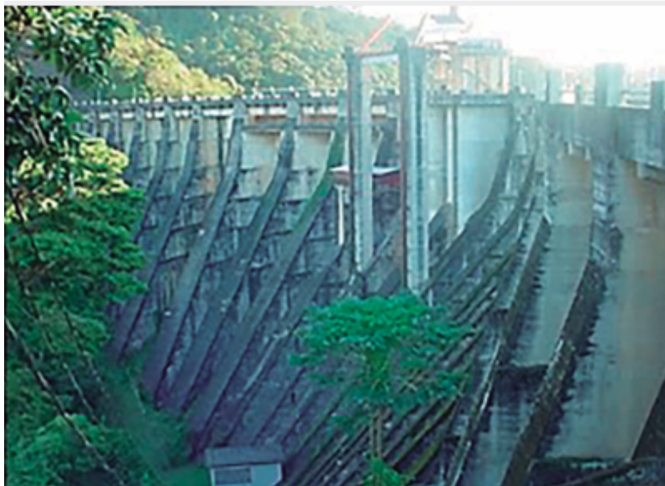
Figura 7 – Barragem de Concreto de Lajes no ribeirão das Lajes.
