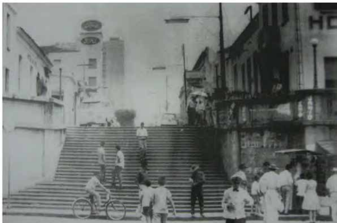
Figura 81: A grande escadaria que conectava a Rua Pedro Amaral e a Estação Ferroviária.
