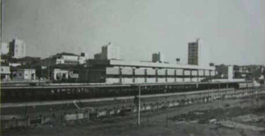
Figura 85: a Rodoviária após sua construção.
