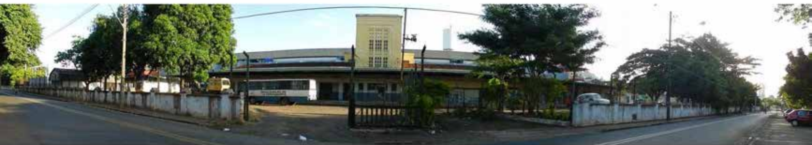
Figuras 55 à 61: O péssimo estado de conservação em que a Estação Ferroviária se encontra na fachada voltada à linha férrea.
