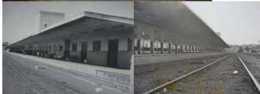
Figuras 49, 50 e 51: Imagens da Estação Ferroviária, sem data. Fonte: Arquivo Público Municipal.
