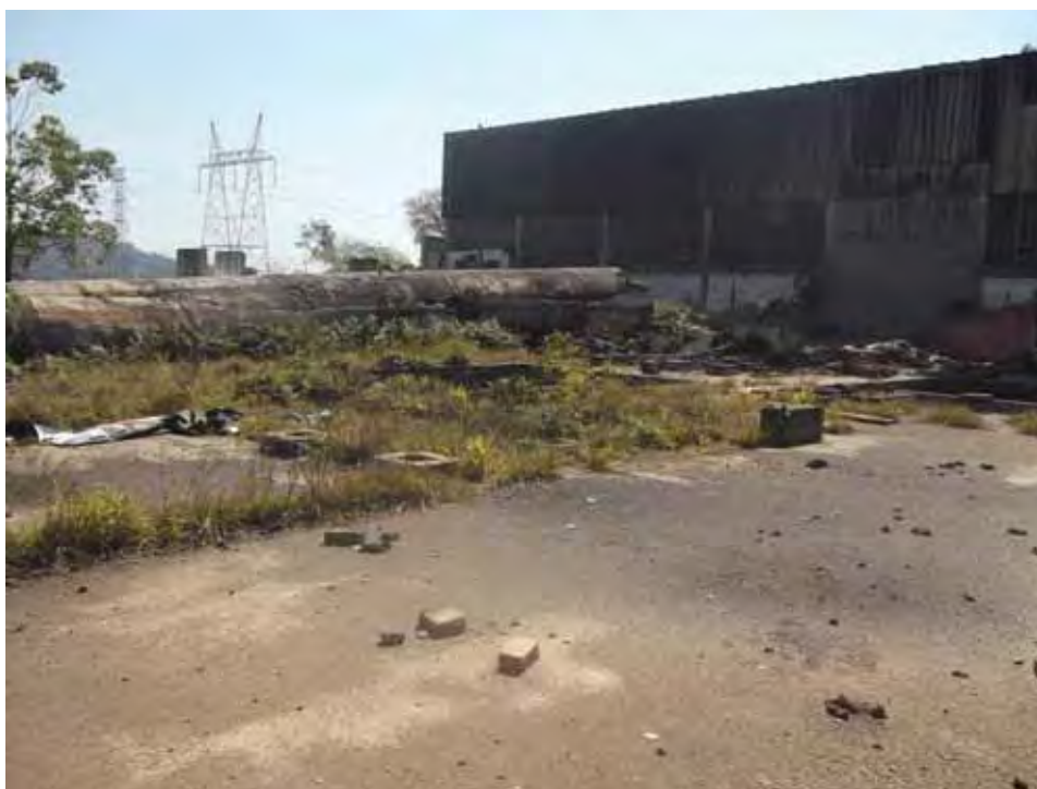
Foto 7: Estruturas da Faé em ruínas.
