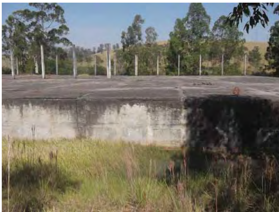
Foto 5: Estrutura de concreto.
