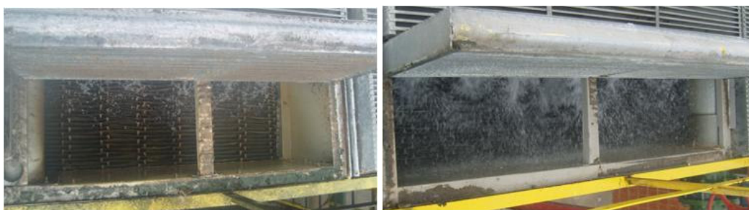
Figura 34 - Espalhamento dos bicos aspersores antes e depois da reforma
