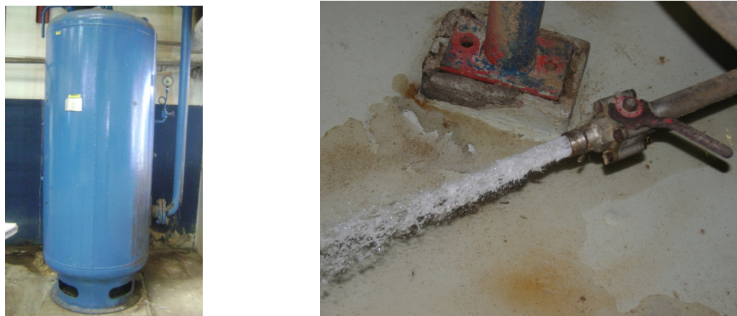
Figura 62 - Reservatório de ar comprimido e dreno de condensado utilizado na indústria
