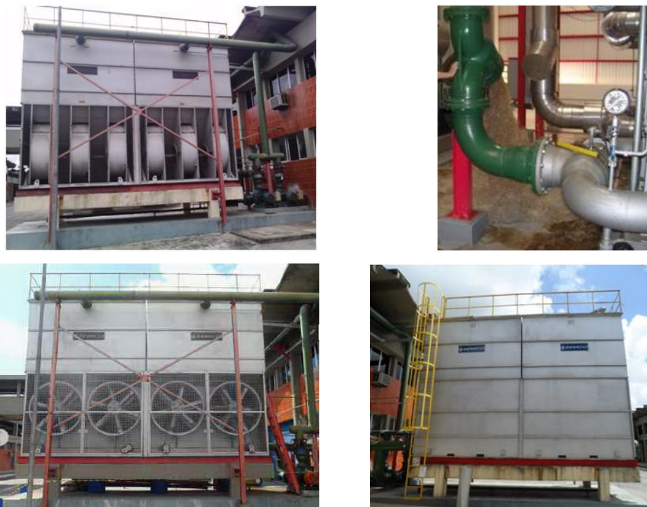
Figura 35 - Reforma das torres de resfriamento e a retrolavagem nos condensadores de placas
