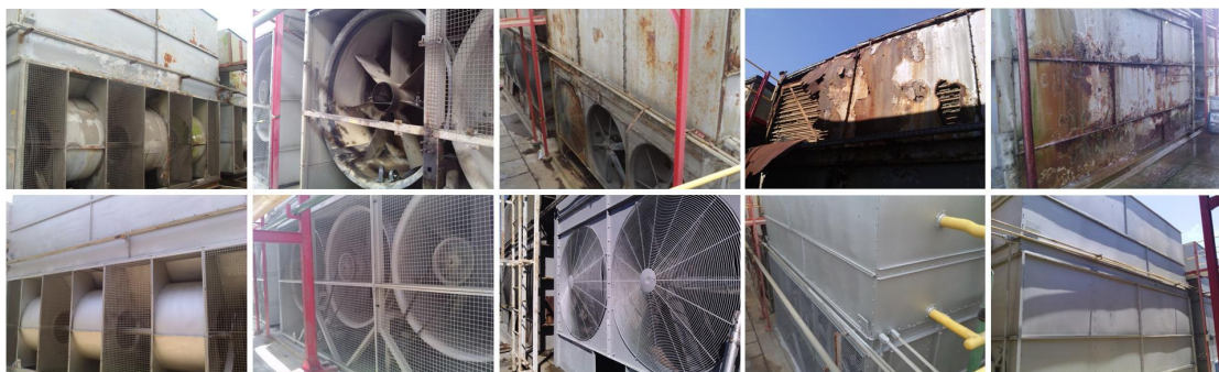
Figura 45 - Reforma dos condensadores evaporativos
