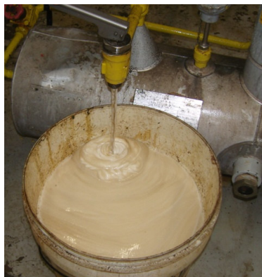
Figura 44 - Drenagem manual de óleo em um evaporador
