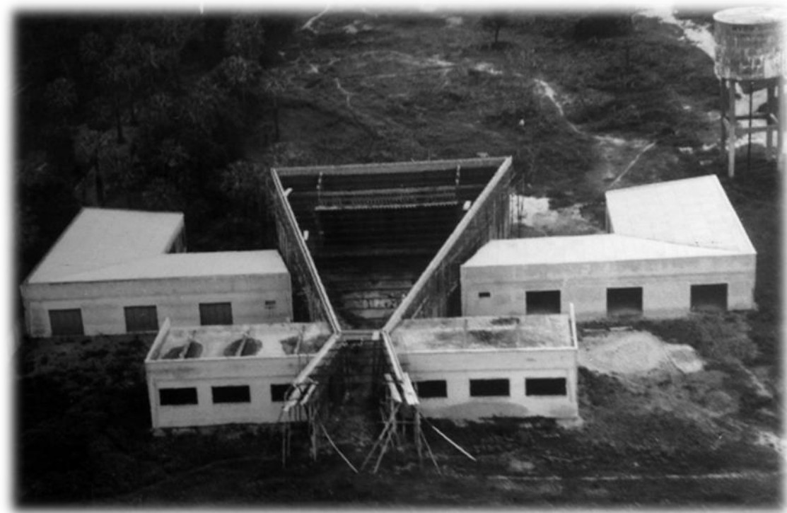
Figura 16: Edifício da Cidade do Catecismo em construção
