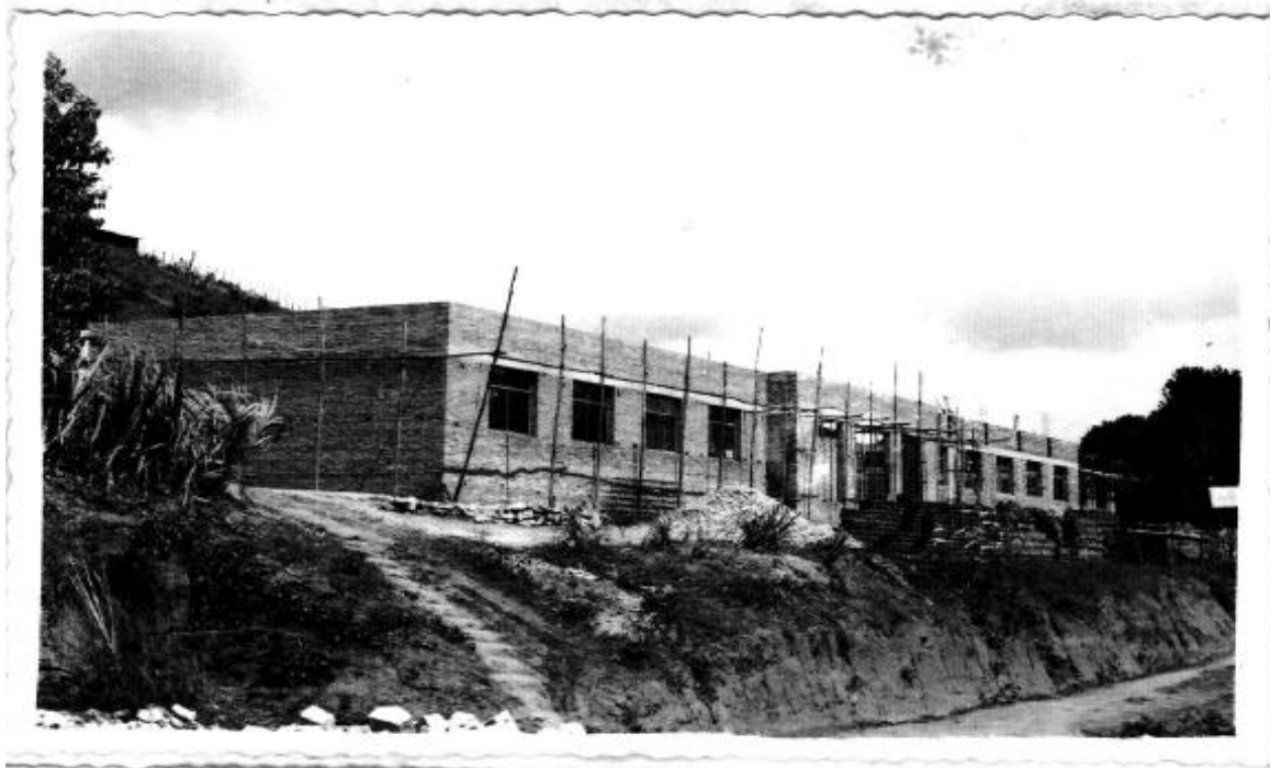
Figura 5: Construção e obra da Escola Normal Regional
