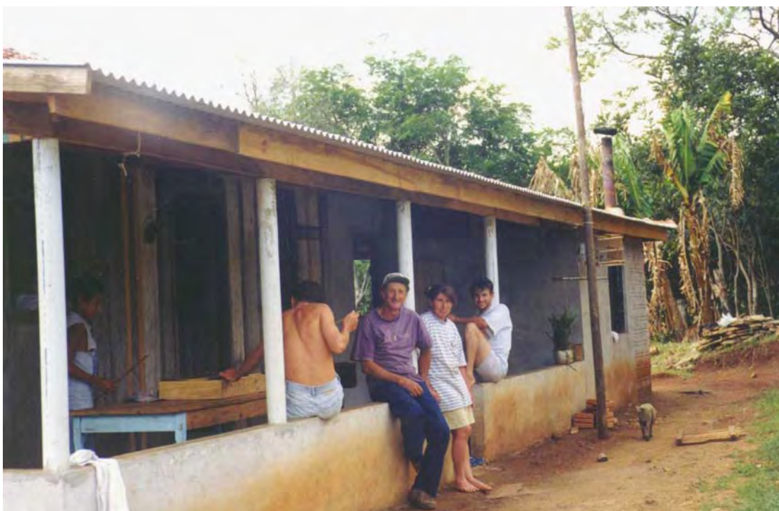
Foto 11: Nova residência de um dos produtores da comunidade de Vila Rica (o mesmo da foto anterior), construída com recursos a fundo perdido do Paraná 12 Meses e com recursos próprios do produtor.
