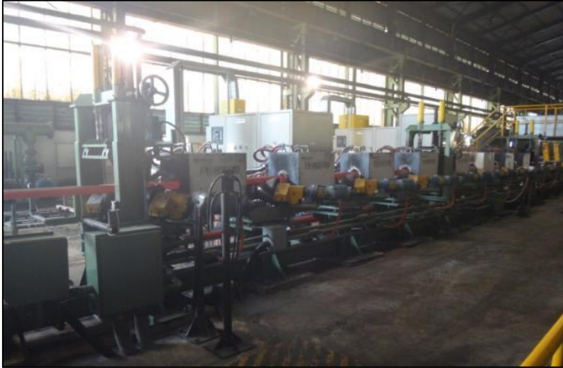
Figura 56 – Linha de revenimento do forno de tratamento térmico
