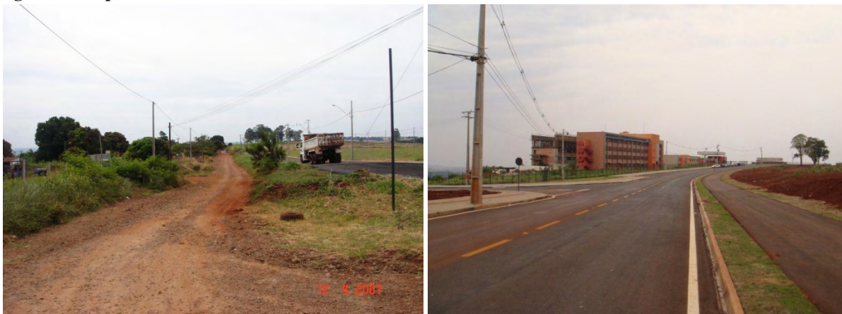
Figura 9: Etapas do asfaltamento de trecho da Estrada dos Pioneiros - UTFPR.
