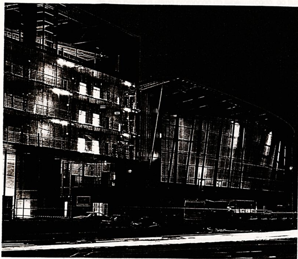
KOOLHAAS. Congrexpo. Vista noturna, quando se pode ver a profundidade superficial pelo jogos de transparência e opacidade dos vidros, as contraluzes, greijas em véus sobrepostos, 71.
