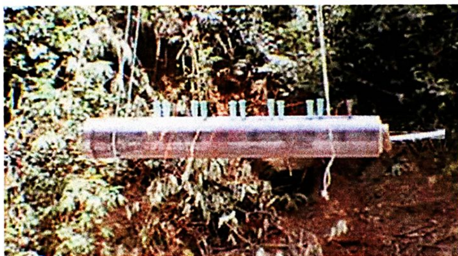
FIGURA 5.13 - Carga explosiva espoletada e pronta para ser detonada
