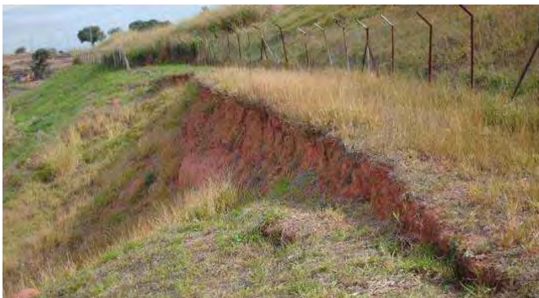
Figura 6.8 – Escorregamento em talude.
