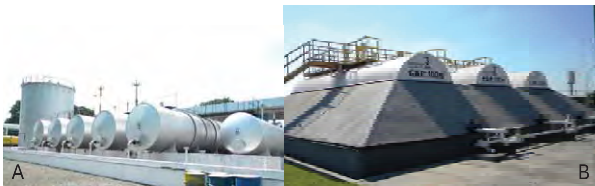
Figura 6.16 - Tanques aéreos (a) e semi-enterrados (b) nos Parques de Abastecimento de aeronaves.
