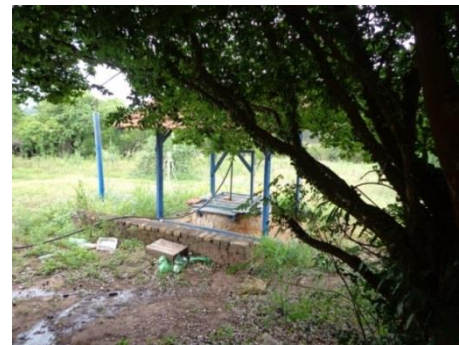
Figura 7.54 - Detalhe do poço cacimba BRU 43.
