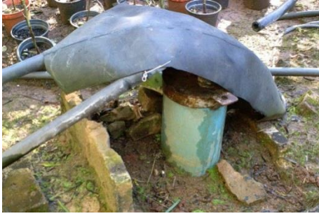
Figura 7.33– SJRP 09 – poço tubular localizado próximo à plantação
