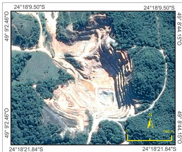
Figura 6: Mina Olho d'Água, Bom Sucesso de Itararé – SP
