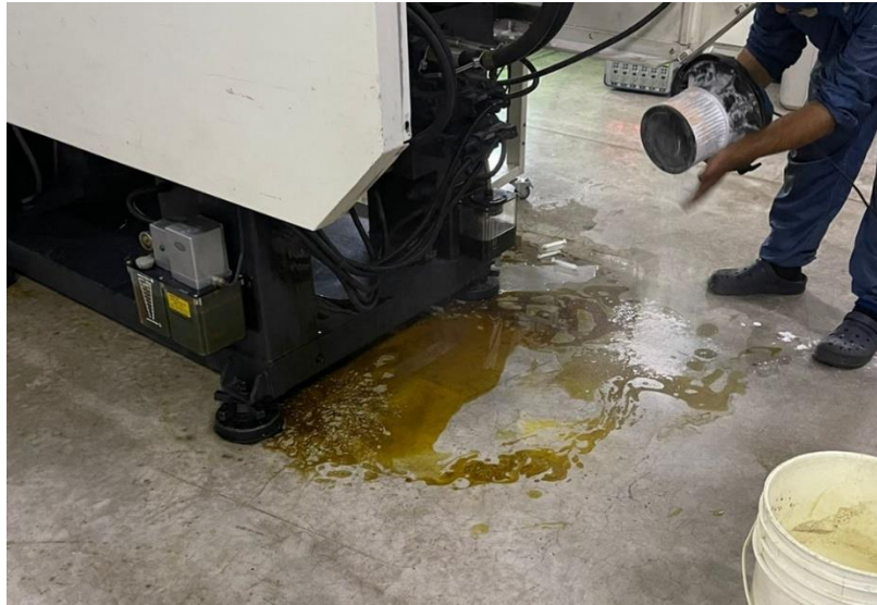
Figura 17 - Vazamento de Óleo de Máquina
