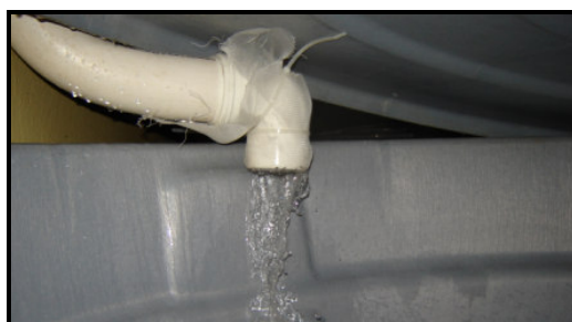
Figura 10: Tela instalada na saída do condutor vertical.
