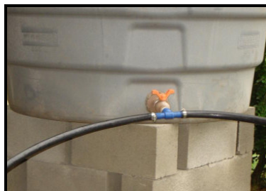
Figura 13: Sistema “T” para distribuir a água coletada.
