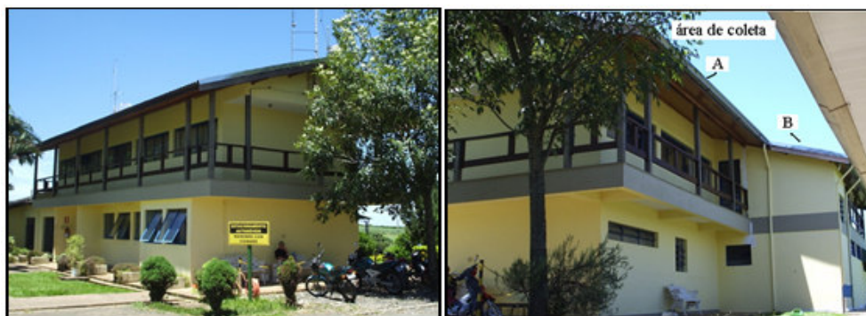
Figura 4: Fachada principal e posterior do prédio utilizado para a captação de água pluvial.
