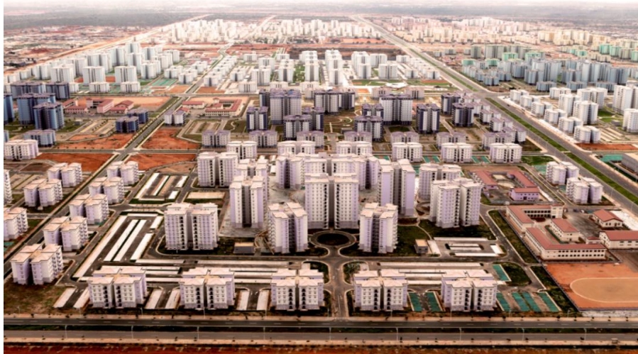
Figura 16 – Centralidade do Kilamba, município de Belas, província de Luanda. Maior projeto habitacional da China na África
