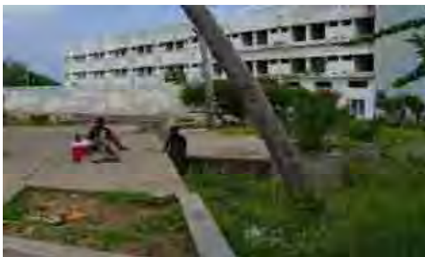
Foto 15: Imagem do Hotel Xai-Xai em ruínas, um exemplo da degradação de infra - estruturas locais. Fonte: Autor, Fevereiro de 2006.
