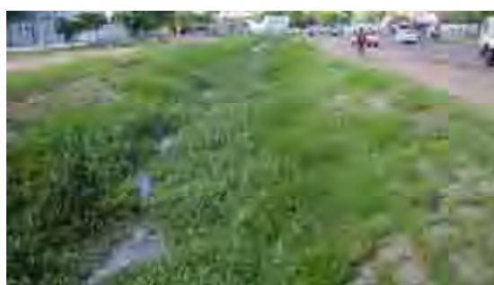
Foto 33. Assoreamento da vala de drenagem das águas negras na capital do país. Fonte: Autor (2006).
