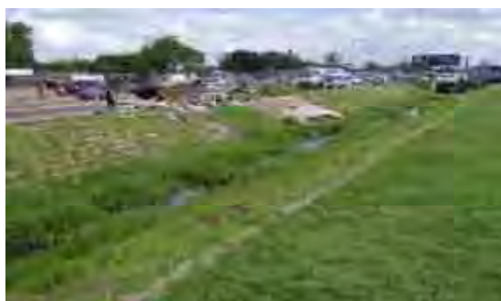
Foto 30: A acumulação de resíduos e o assoreamento da vala de drenagem em Maputo. Fonte: Autor, (17 de Fevereiro 2006).
