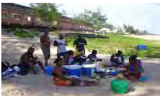
Foto 27: A degradação das infra-estruturas (no fundo) na praia de Xai-Xai não é motivo inibidor do lazer dos populares idos de vários cantos de Xai-Xai. O PID prevê a sua reabilitação que ainda não se sabe quando vai começar. Fonte: Autor (14.2.2006).
