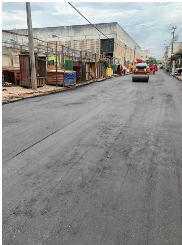
Figura 35 - Recuperação asfáltica da rua Senhora Santana
