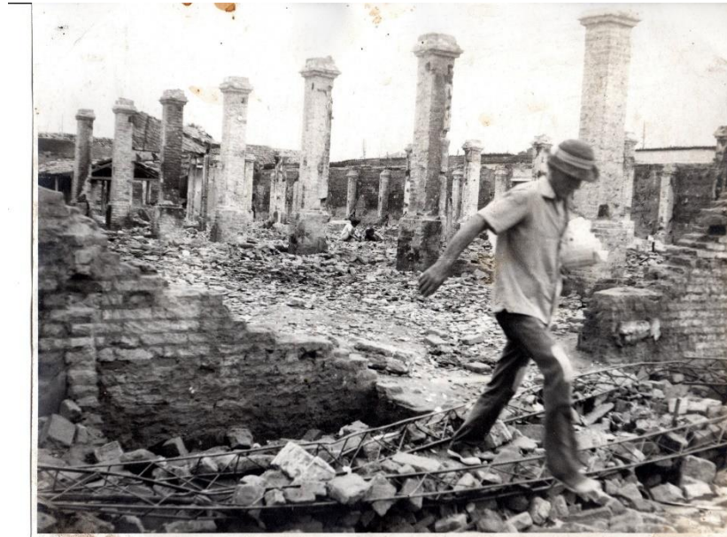
Figura 26 – Registro fotográfico do mercado Central após incêndio na década de 1970
