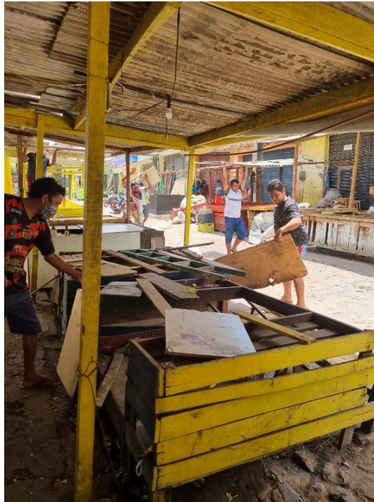
Figura 34 – Desmontagem das barracas da rua Senhora Santana
