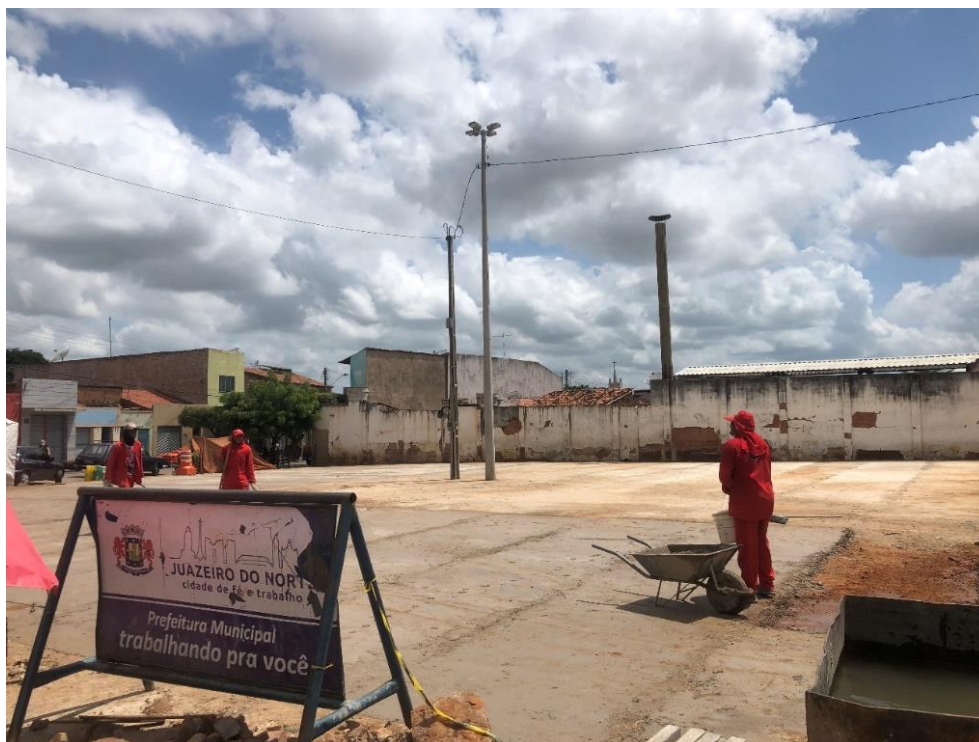
Figura 23 – Obras do pátio ocioso em 2022
