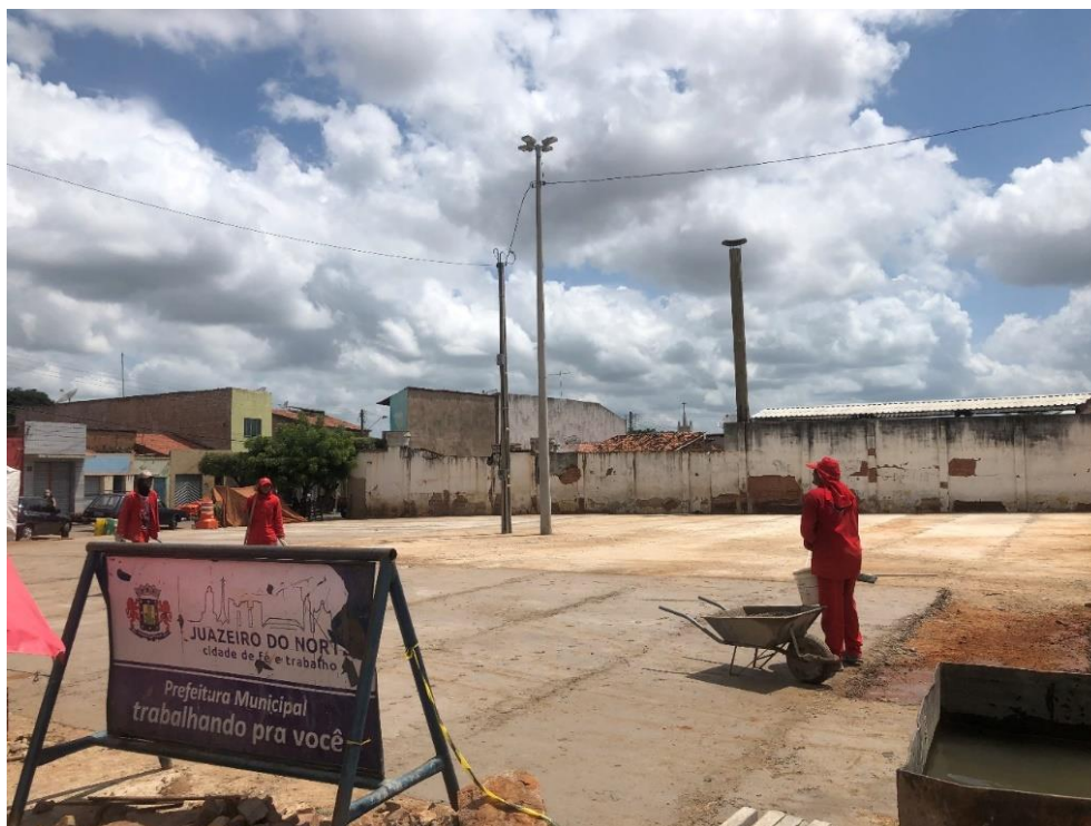
Figura 24 - Obras do pátio ocioso em 2022
