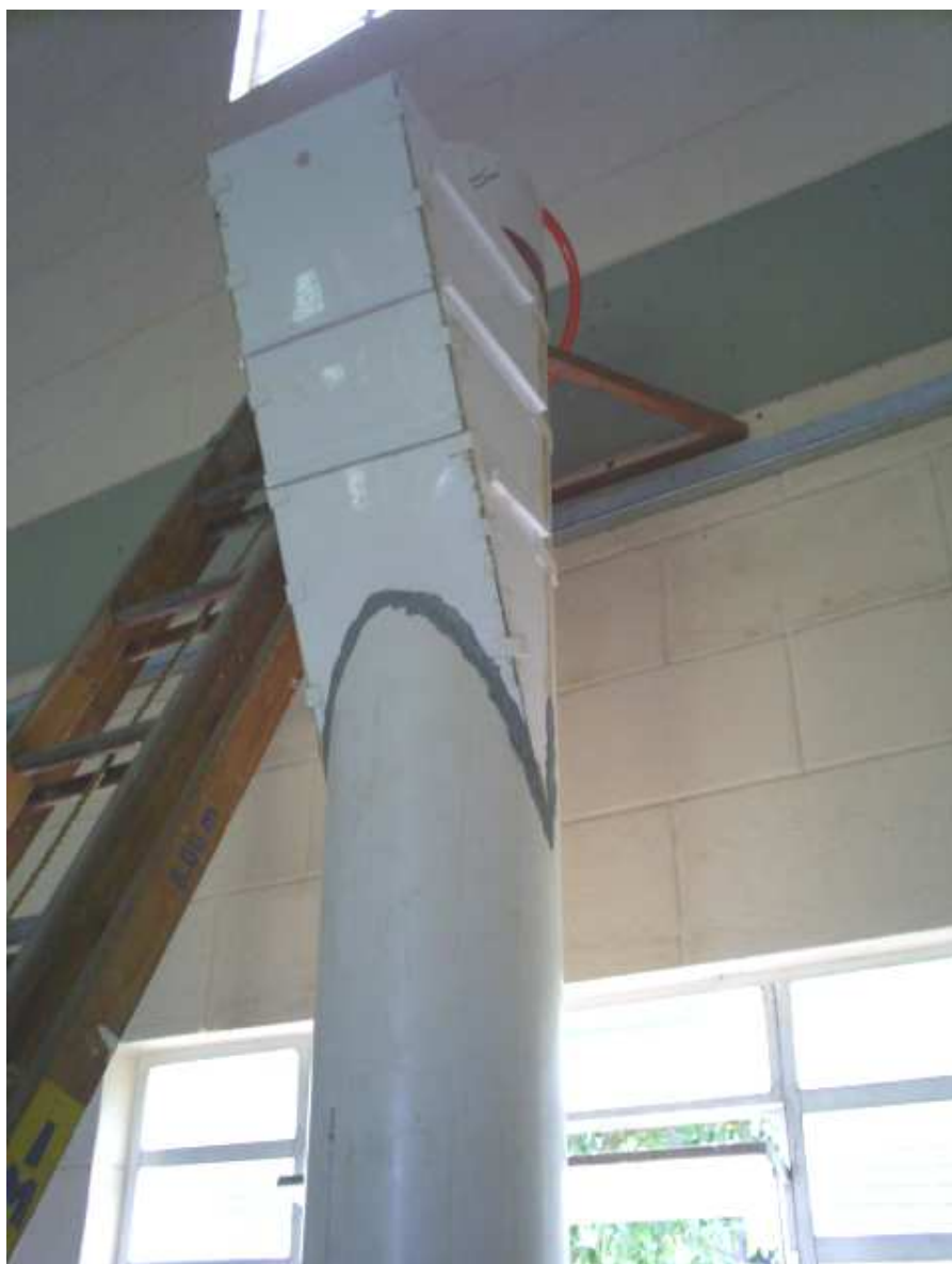
Figura 5.2: Vista externa do decantador
