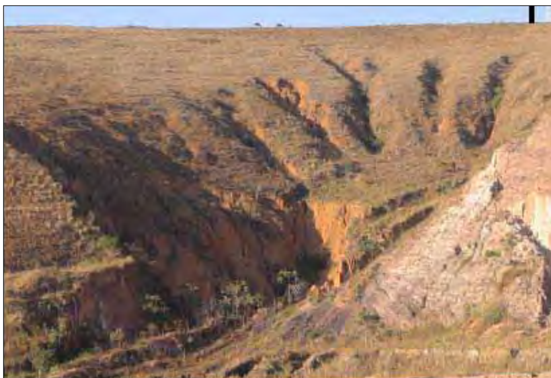
Foto 02: Feições erosivas na BR-116, próximo a São José dos Campos.
