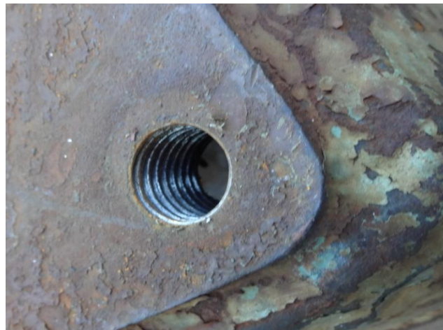
Figura 7. Rosca interna usinada na base inercial.
