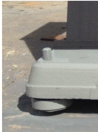
Figura 28. Ponto de sustentação da base inercial.
