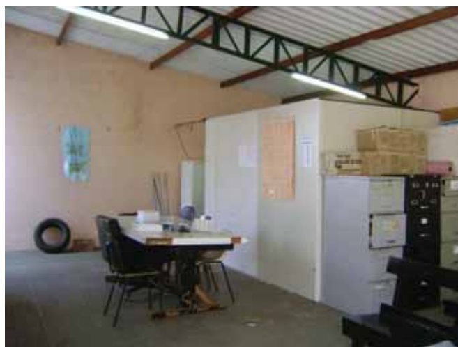
Figura 7. Sala dos ACS e a copa ao fundo, cobertura composta por telhas de fibrocimento. Fonte: Acervo da autora, 2010.
