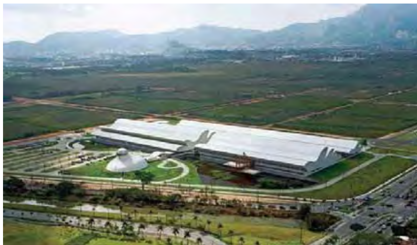
Figura 17. Vista aérea do Hospital Sarah Rio de Janeiro. Fonte: Arcoweb, acesso em 2012.
