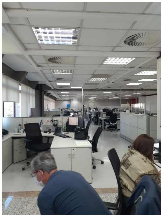
Figura 43 - Sistemas do setor administrativo - Sesc Bauru.
