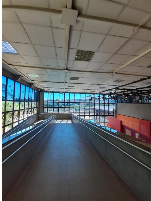
Figura 34 - Vista para área externa - Sesc Bauru.
