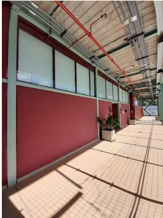
Figura 74 - Varanda de acesso para o setor administrativo - Sesc Birigui.
