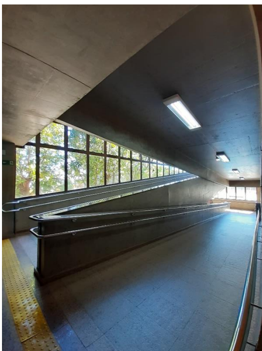
Figura 29 - Rampas de acesso - Sesc Bauru.
