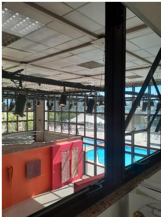
Figura 35 - Janelas setor administrativo - Sesc Bauru.
