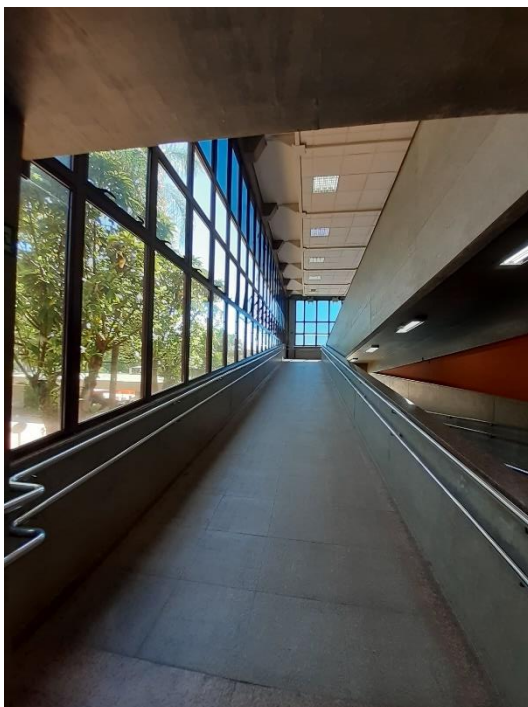
Figura 85 - Janelas da rampa - Sesc Bauru.
