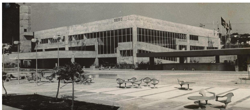
Figura 33 - Área externa Sesc Bauru em 1977.
