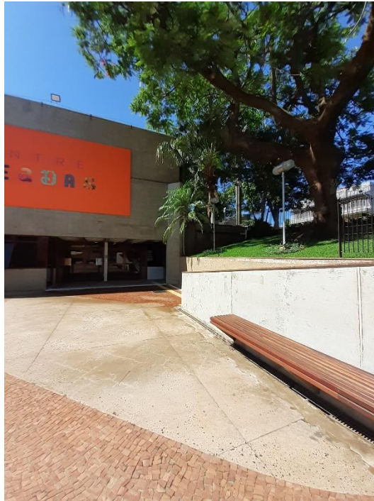
Figura 37 - Fachada lateral - Sesc Bauru.
