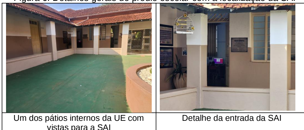
Figura 6: Detalhes gerais do prédio escolar com a localização da SAI
