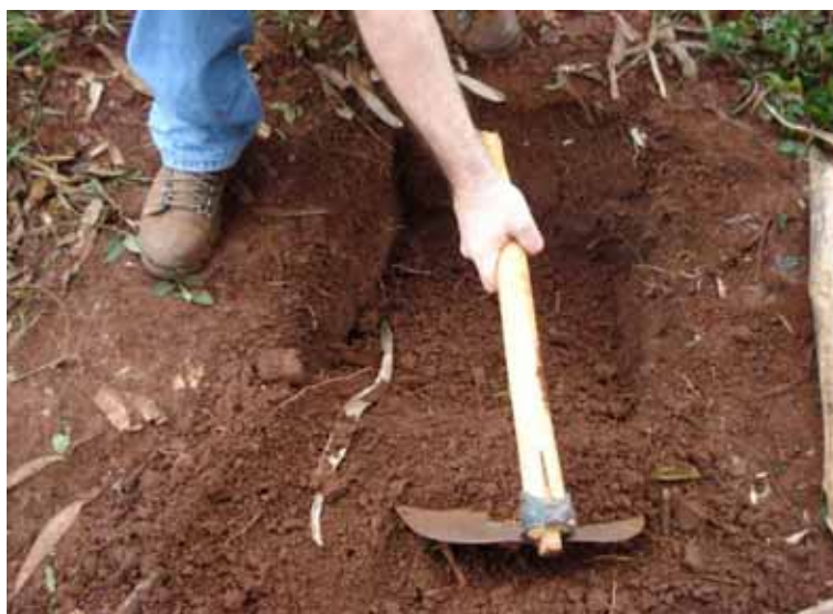
Figura 42: Buraco sendo fechado com solo local.
