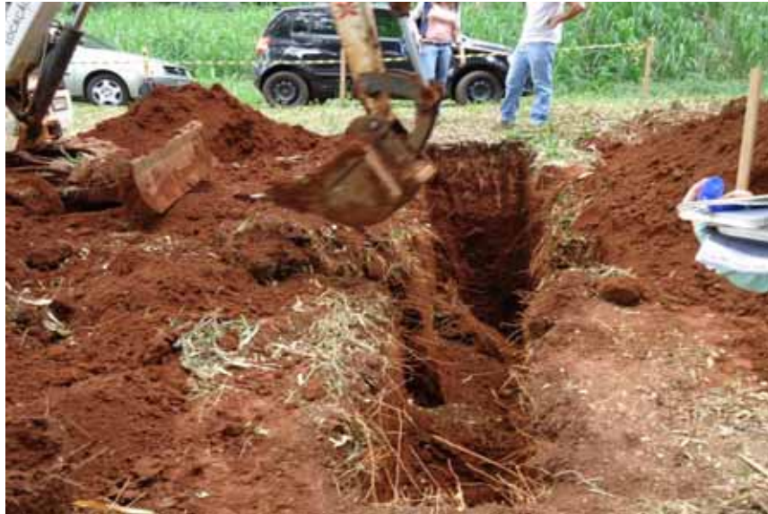
Figura 20: Escavação de trincheira para caracterizar os horizontes existentes na área.
