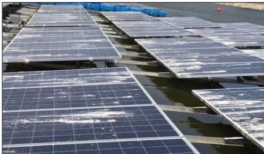
Figura 46 – Dejetos de pássaros em módulos flutuantes
