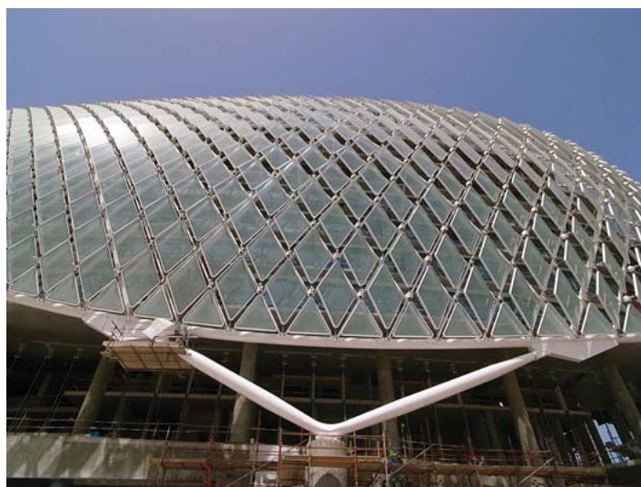
Figura 29 – Yas hotel – Detalhe da estrutura da cobertura em LED
