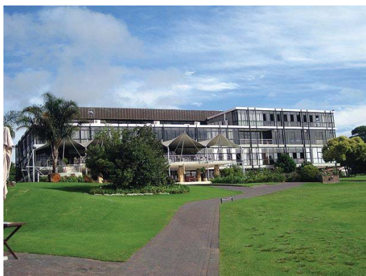
Figura 8 – Vista fachada interna do hotel
