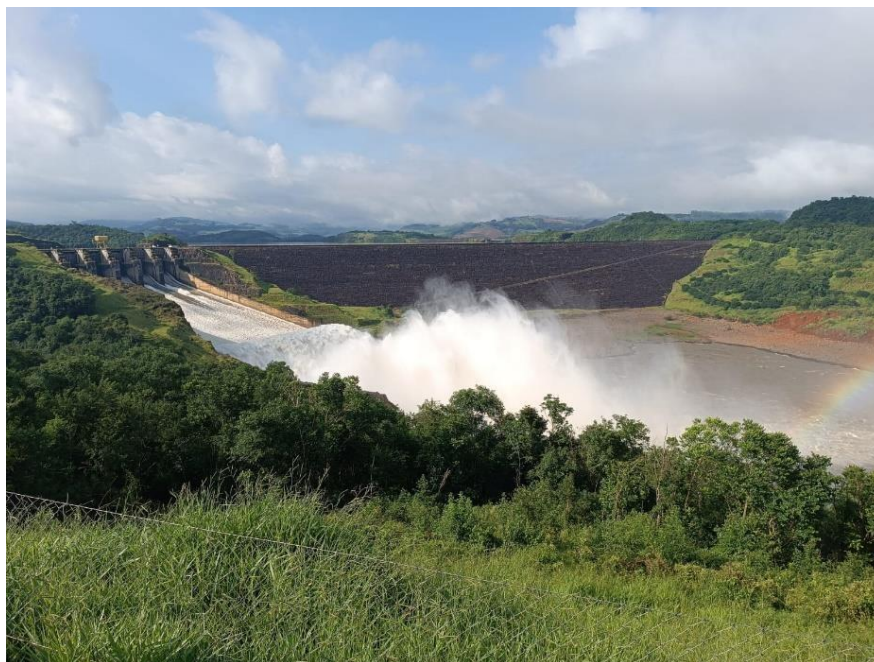
Foto 20 - Vertedouro 1 da UHE Itá aberto
