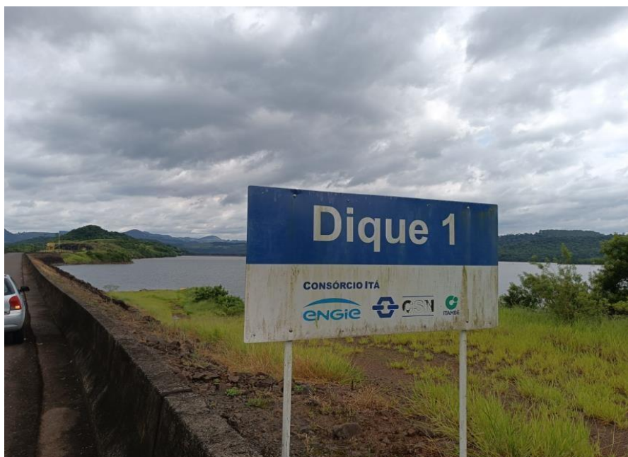
Foto 21 - Dique 1 da UHE Itá
