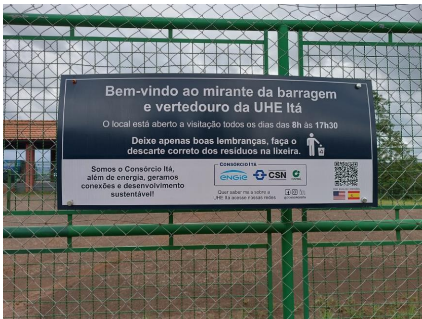
Foto 24 - Placa fixada na entrada do mirante do vertedouro 1 da UHE Itá
