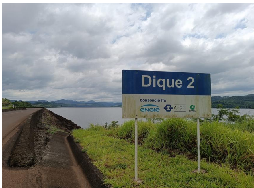
Foto 22 - Dique 2 da UHE Itá
