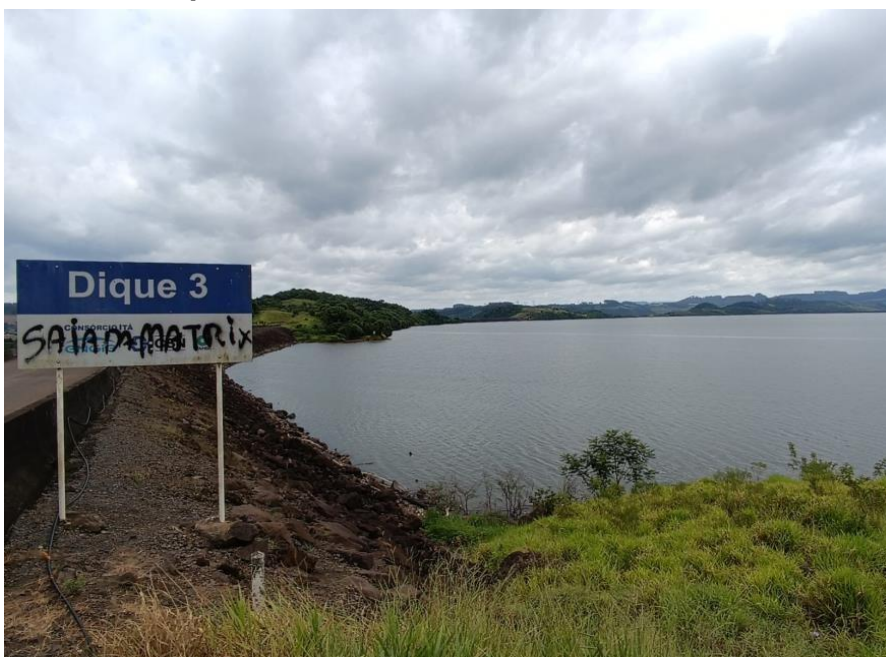
Foto 23 - Dique 3 da UHE Itá
