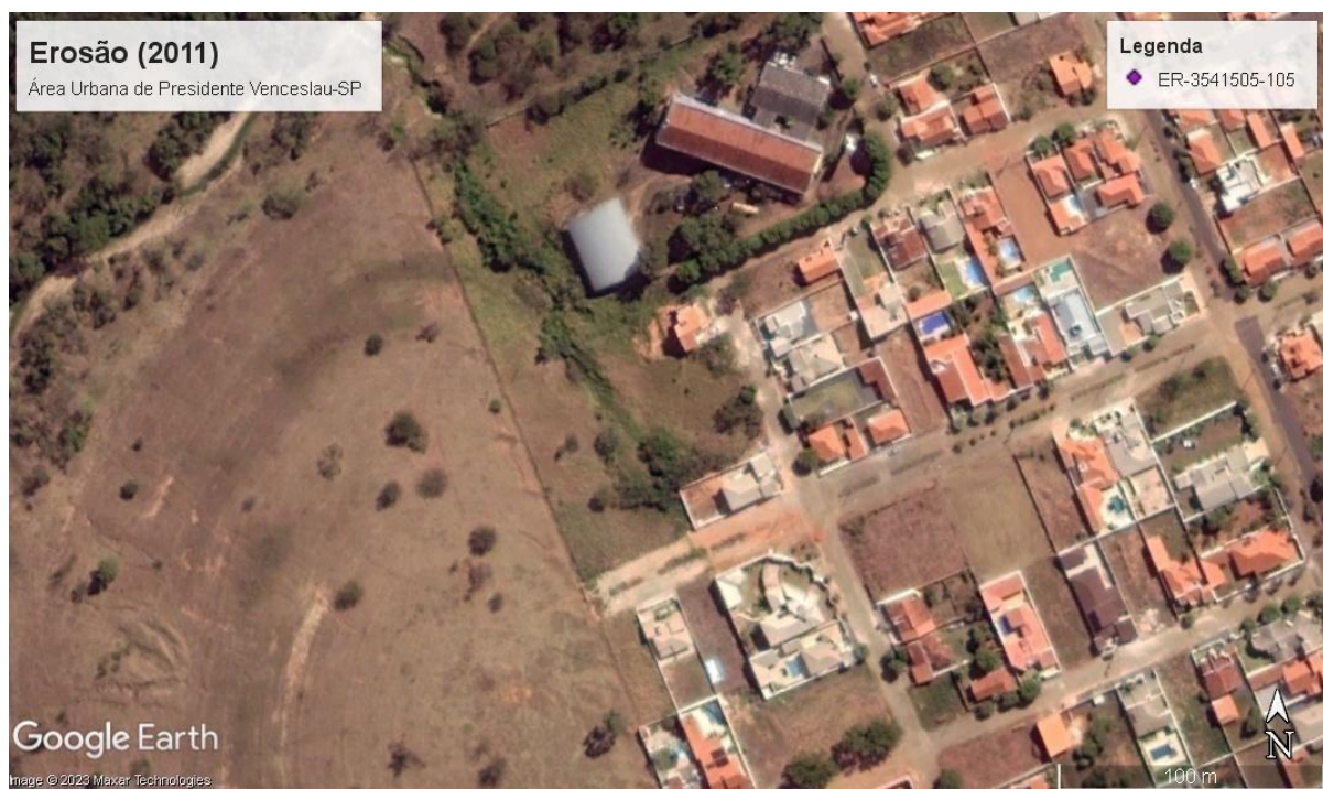
Figura 36 - Erosão urbana 2 em Presidente Venceslau-SP em 2011
