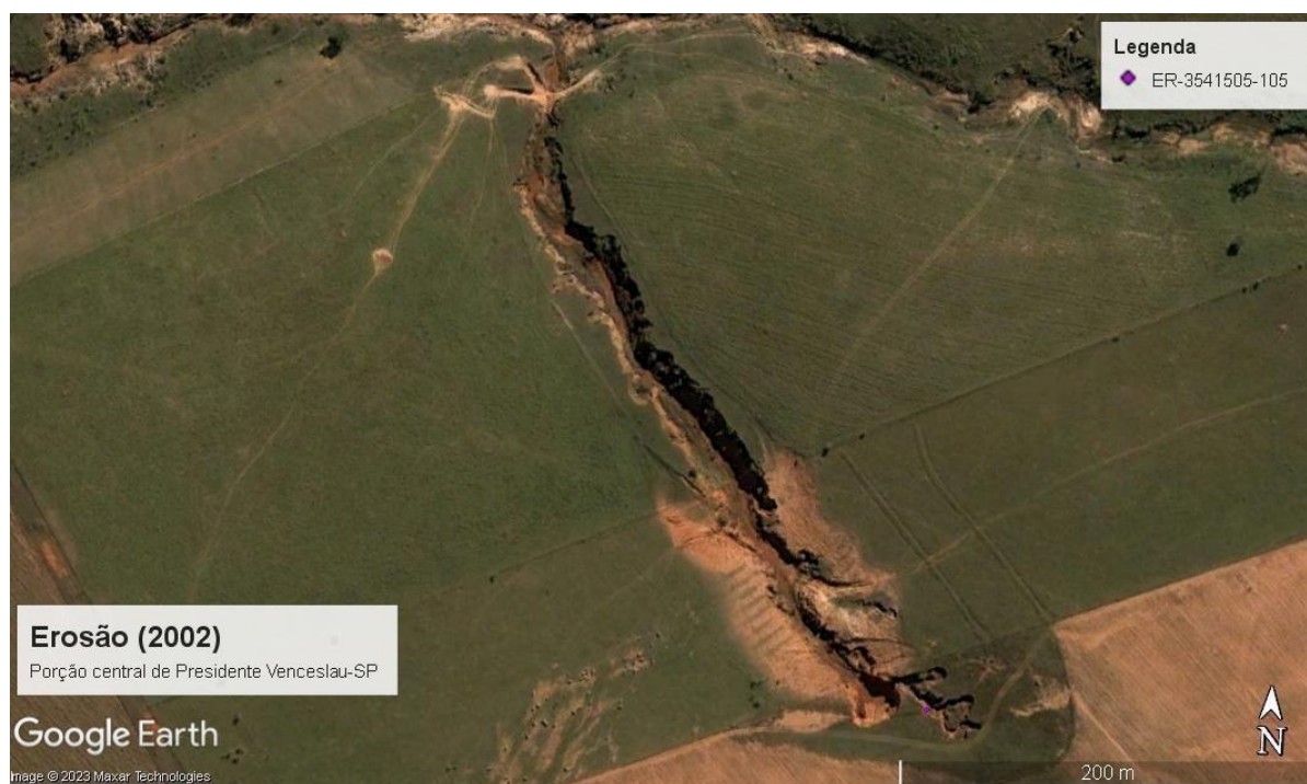
Figura 26 - Erosão na porção central de Presidente Venceslau-SP em 2002
