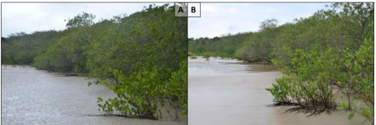
Figura 70 – A) Foto da campanha 2 (15/06/2018) nas adjacências do perfil 1. B) Foto da campanha 17 (23/04/2019), na mesma região do perfil 1. Nota-se na primeira imagem a vegetação sendo soterrada. Na segunda imagem vemos as mesmas plantas com as raízes expostas, pois havia se iniciado o processo erosivo desde a saída 13 (Fotos: Buchmann).
