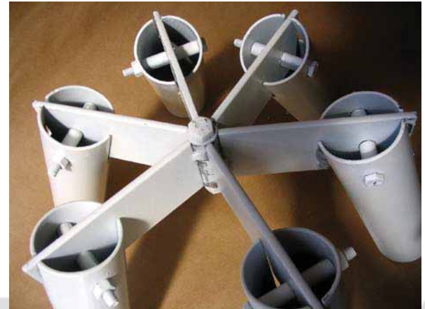
Figura 41 – Fotografia do Protótipo de Nó Tri-Ortogonal de seis folhas Fonte: DINIZ, 2006.
