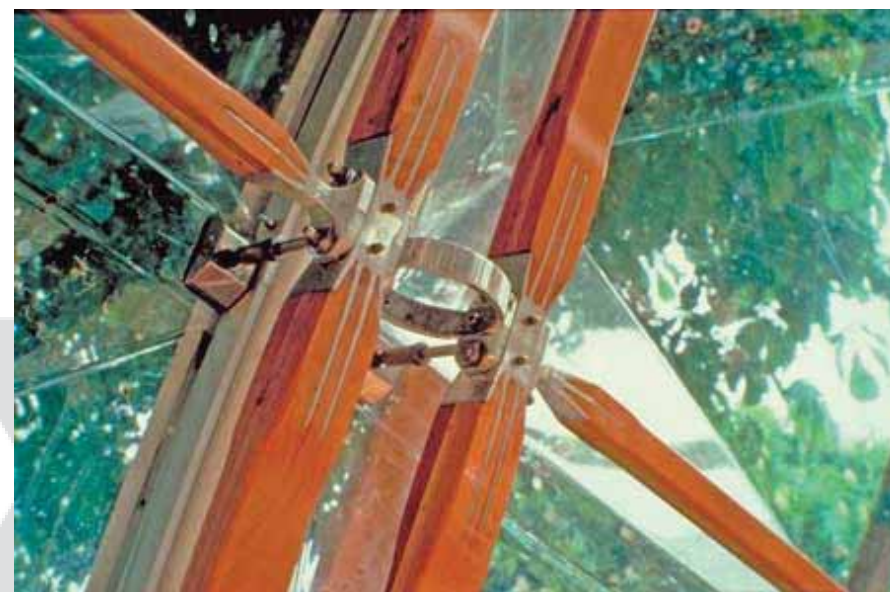
Figura 24 – Detalhe de junção entre os elementos e entre os módulos. Fonte: http://struturemag.org/article.aspx?articleID=476 .
