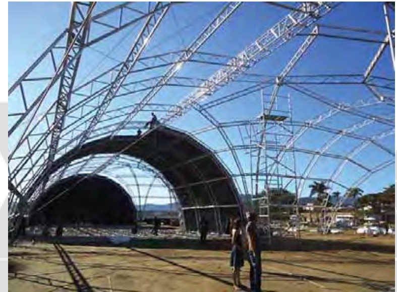
Figura 13 – Montagem da Tenda dos Autores em andamento. Estrutura metálica de alumínio.
