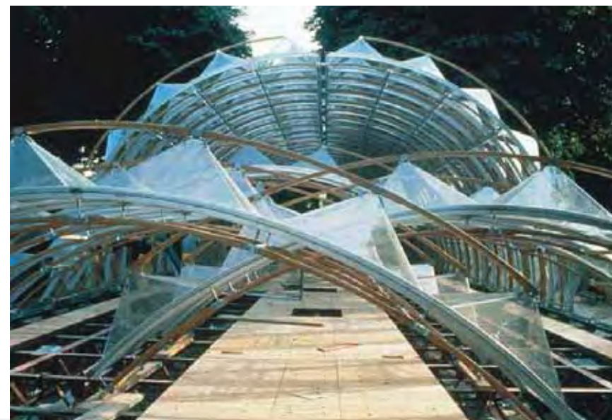
Figura 22 – Montagem dos módulos do Pavilhão IBM Fonte: http://www2.ufp.pt/~avoliv/trab%20teo%20alunos/piano-marcos.pdf .
