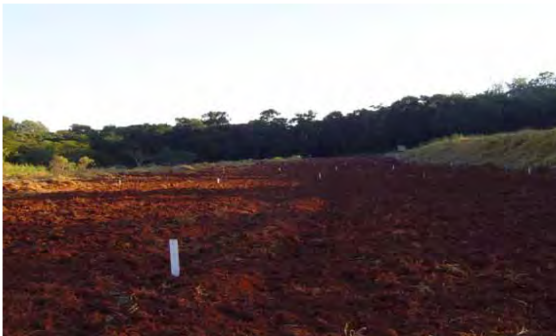
Figura 3 – Vista da pista 1 - superfície mobilizada
