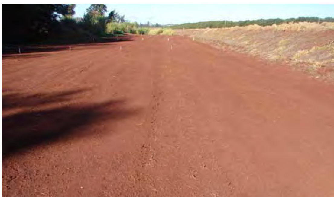
Figura 5 – Vista da pista 3 - superfície firme.
