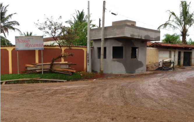
Figura 11: Convívio Nosso Recanto com seu fechamento em fase de finalização, aparentemente uma tendência neste bairro.
