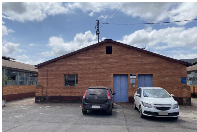
Figura 13: Onde funcionava a cantina
