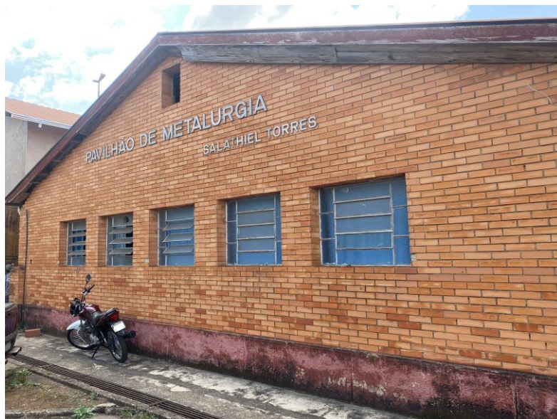
Figura 18: Pavilhão de Metalurgia
