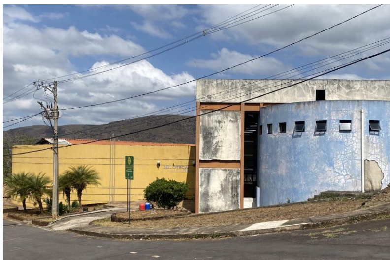
Figura 24: Prédio da Biblioteca
