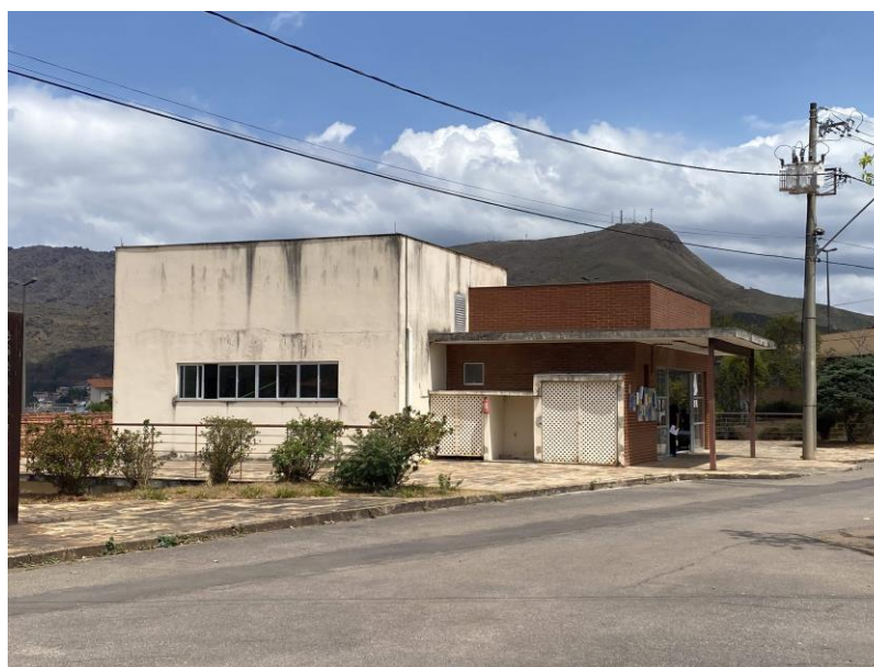
Figura 14: O espaço onde funciona a cantina atualmente
