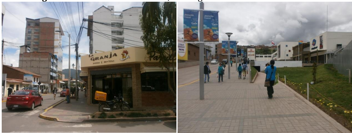
Figura 77: Zona Sudeste de Cuzco, às margens da Avenida de la Cultura.
