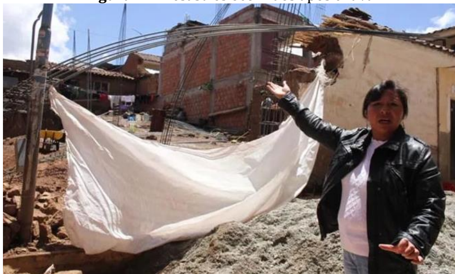
Figura 17: Desastres ocorridos após chuva.
