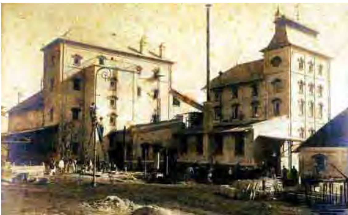
Ilustração 8. Obras de construção da fábrica da Companhia Antártica Paulista, inaugurada em 11 de agosto de 1911. Data: 1911. Fotografia: Ernesto Kuhn. Registro: 175-APH-RP. Fonte: Arquivo Público e Histórico de Ribeirão Preto.
