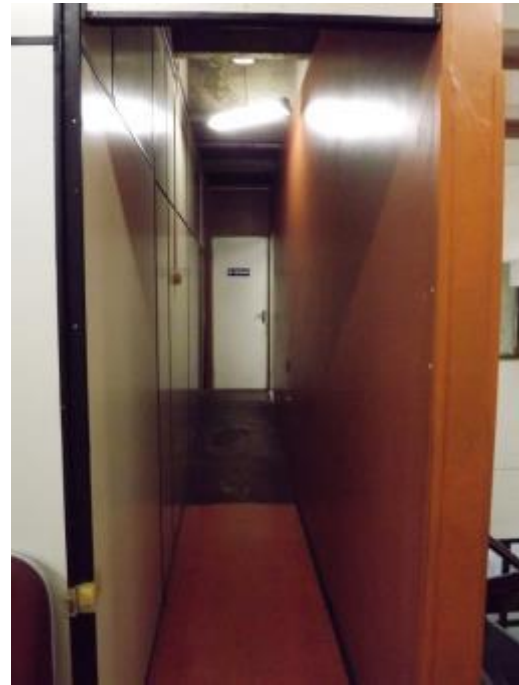
Imagem 59. N - Vista para o banheiro feminino.
