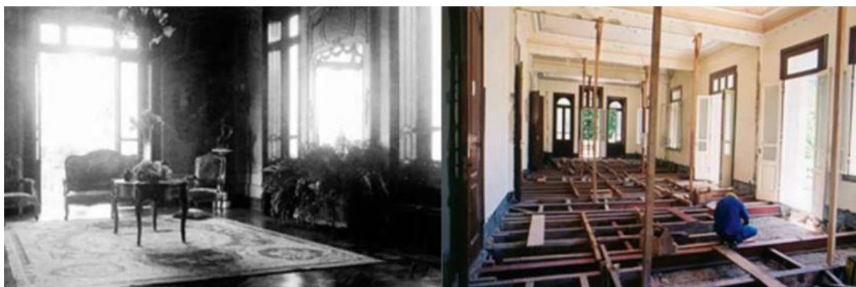
Imagem 82. Palacete - À esquerda no século 20 e à direita durante a reforma.
