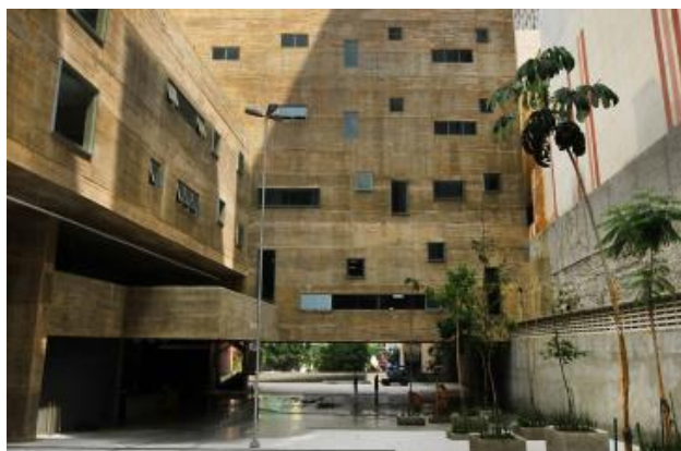
Imagem 65. Praça das Artes - detalhes das aberturas.
