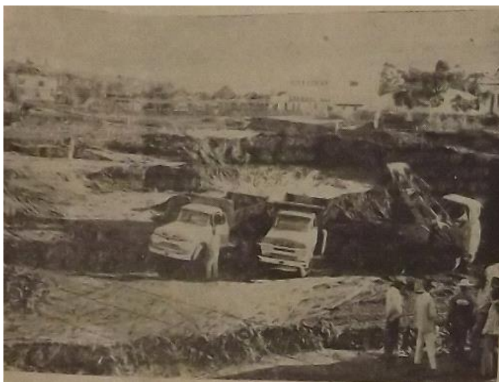
Imagem 29. Construção da Rodoviária de Presidente Prudente.
