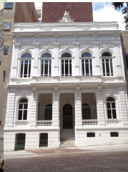
Imagem 69. Fachada do Conservatório em 2013.
