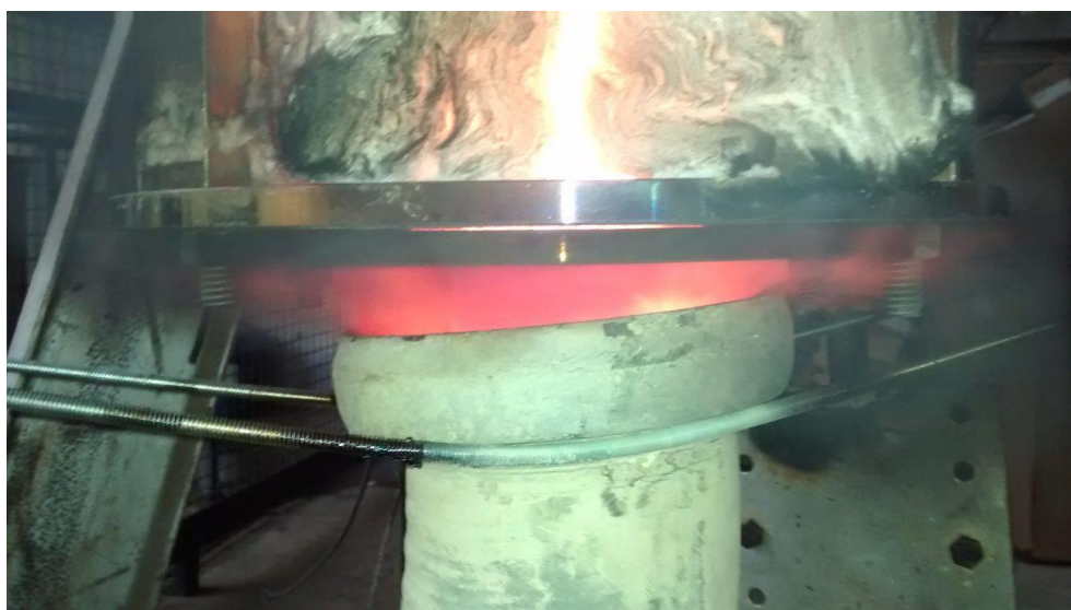
Figura 4.22 - Ocorrência de fuligem durante a operação com baixos excessos de ar
