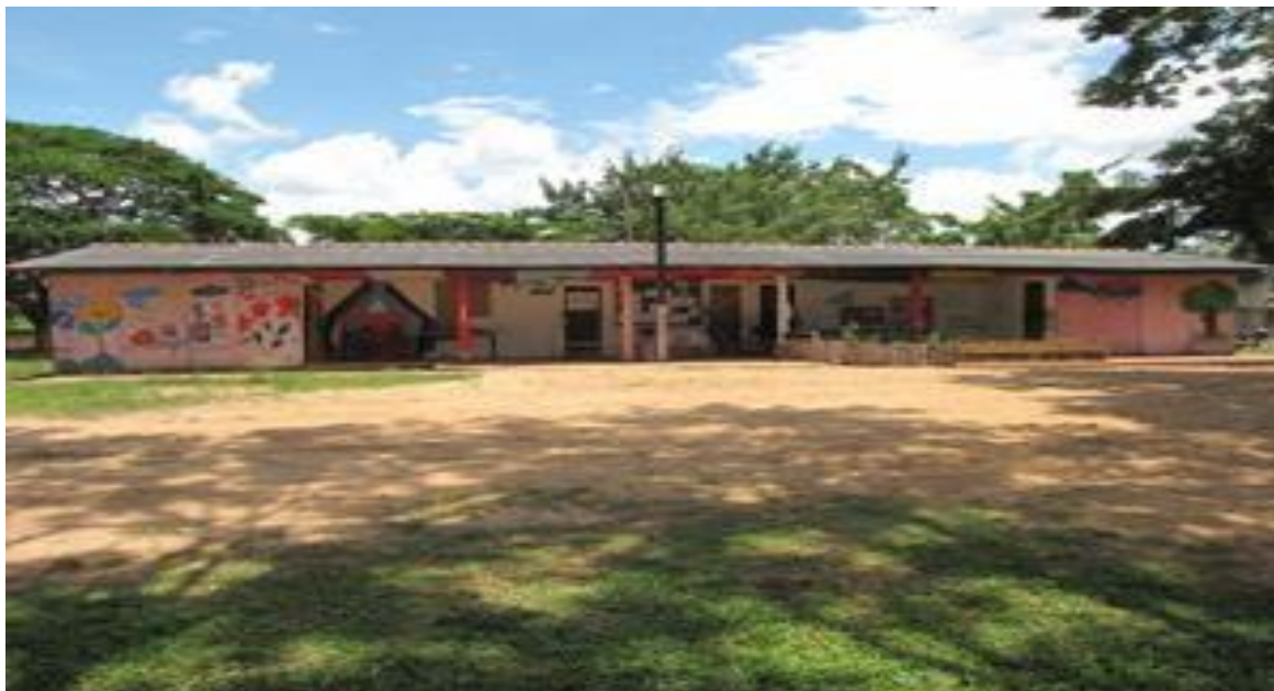
Figura 05 – Após a construção a escola ficou assim.
