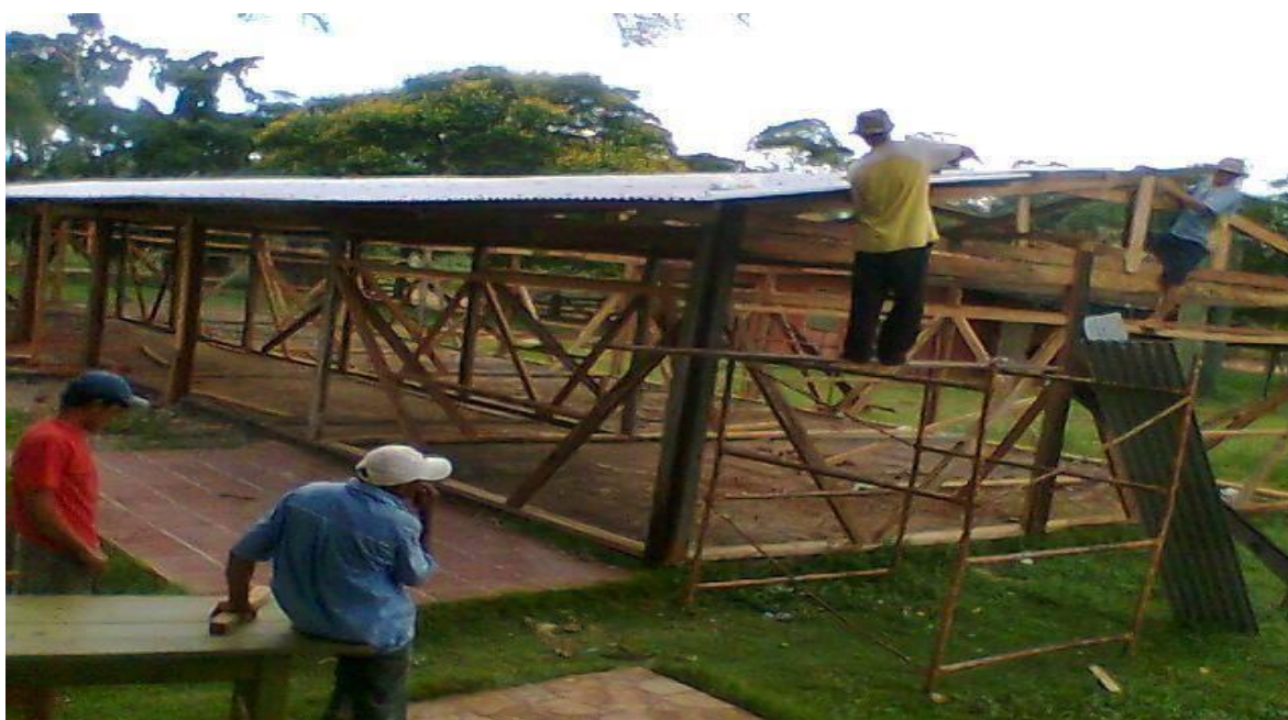
Figura 04 – Construção da escola
