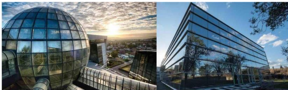
Figure 4 - Réhabilitation des bâtiments 3 et 4 École d'ingénieur Sigma
