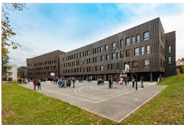
Figure 6 - Restructuration Lycée Honoré d'Urfé Saint-Etienne (42)
